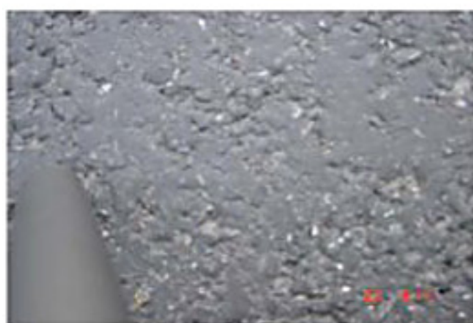
A3 bei Montabaur: Asphaltbelag mit stark angereichertem Bitumen an der Oberfläche vor der TrackJet® -Bearbeitung. Griffigkeit ca. 58—59 SRT- Punkte
